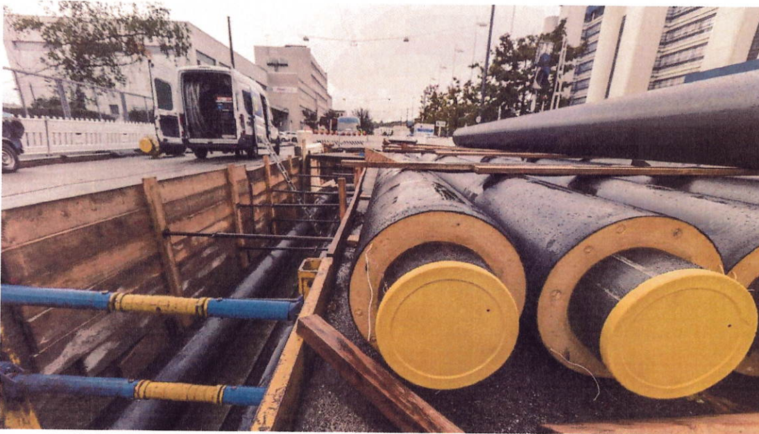
In Feuerbach wird das Fernwärmenetz erweitert. Foto: Lichtgut/Leif Piechowski
